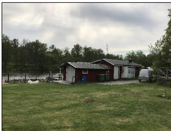
Figur 2-1. Sjömacken sett från nordost. I byggnaden förvaras bland annat invallade cisterner med diesel
